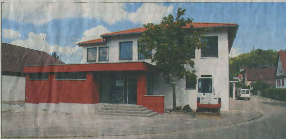
Die Eberdinger Gemeindehalle präsentiert sich in neuem Look.
